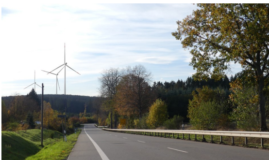
Windenergieanlagen, Windpark "Zerfer Schneeberg", Teil-Sicht vom Hirschfelderhof
