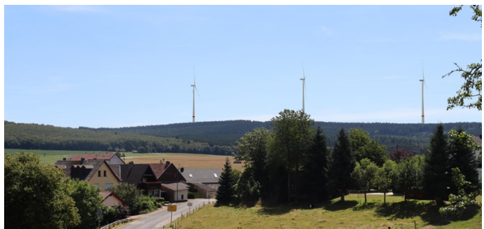
Windenergieanlagen, Windpark "Zerfer Schneeberg", Teil-Sicht von Oberzerf
