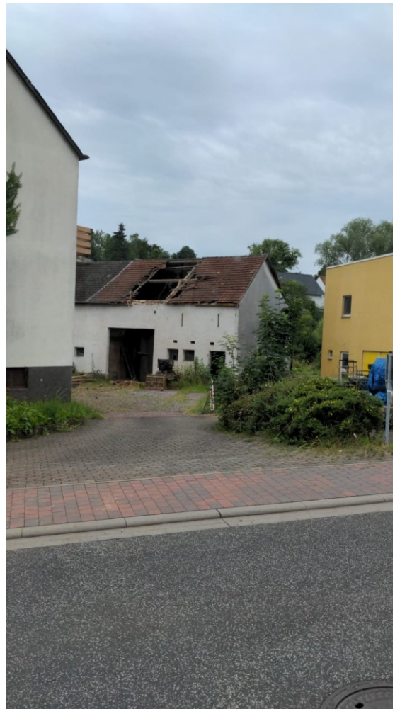
Beginn Abriss Scheune am Großbach 12.07.2021
