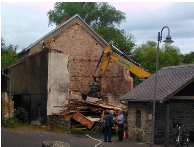
Abriss Haus Glaub 08.07.2021
