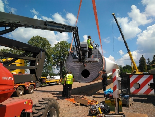
Vorbereitung; Montage eines Rotors auf einen Selbstfahrer
