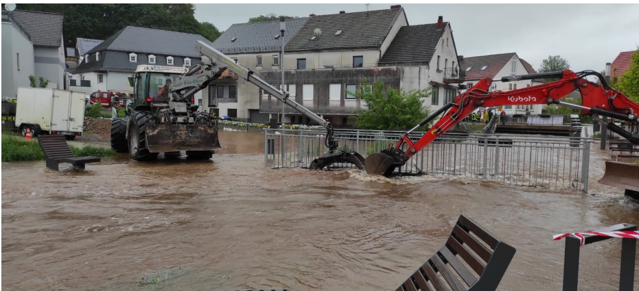
Sicherung der Fußgängerbrücke am Marktplatz (Entfernung von Treibholz)
